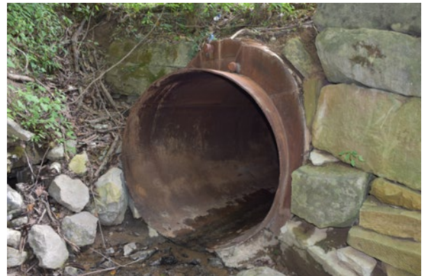
(d) Steel Casing Pipe
