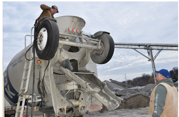
(d) Adding Foam to the Mixer Drum
